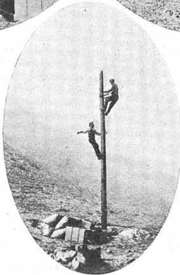
Preparando la colocación de crucetas y rios-tras a pesar del viento helado de la hora temprana.
