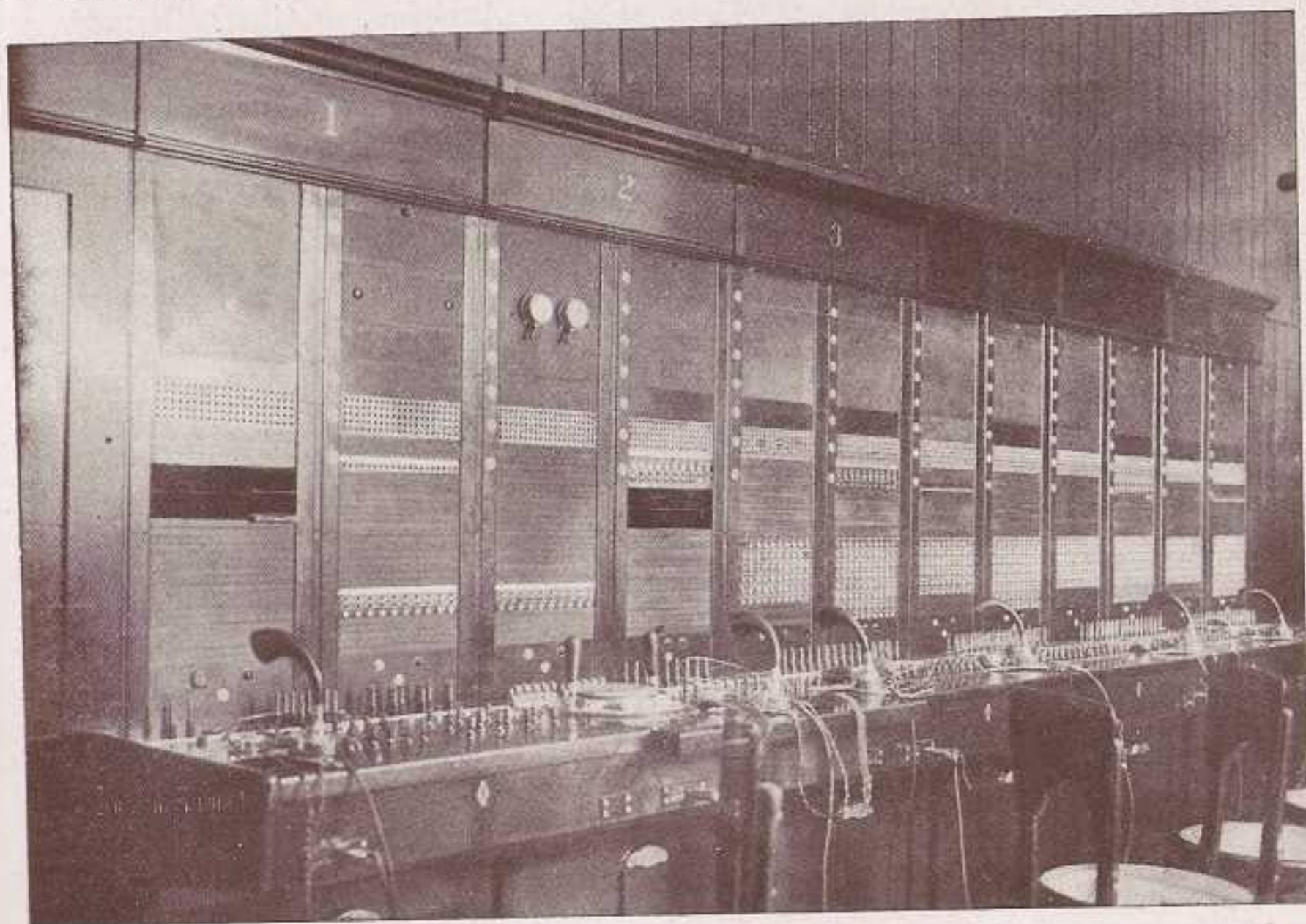
Cuadro múltiple, urbano e interurbano, instalado en Ceuta por la Compañía Telefónica Nacional de España, equipado para 300 líneas y con capacidad para 3.000
